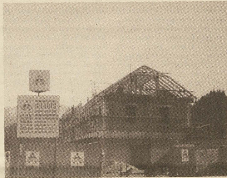
Tesarji končujejo dela na ostrešju, potem pa je potrebno narediti samo še fasado in urediti zunanjo okolico.
