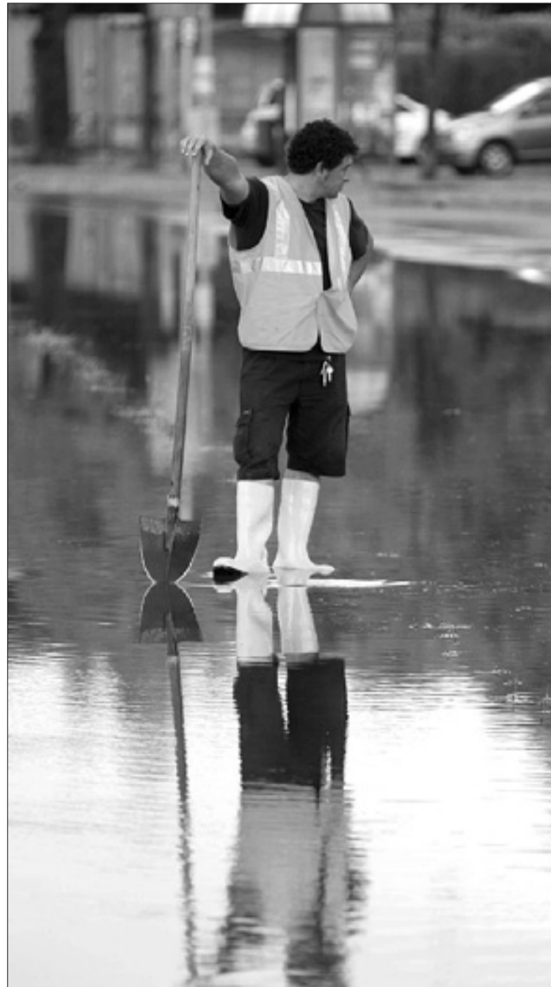
Potem ko je odmašil jaške, opazuje odtekanje vode
