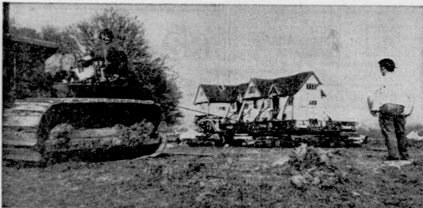
VSA HISA SE SELI — V angleškem kraju Sudbury so zgradili veleblagovnico. Lastnik hiše na sliki pravi, da mu nove stavbe zastirajo razgled, zato se je odločil za preselitev kakih štiristo metrov daleč. Posnetek kaže hišo na valjih s premerom 150 centimetrov.
