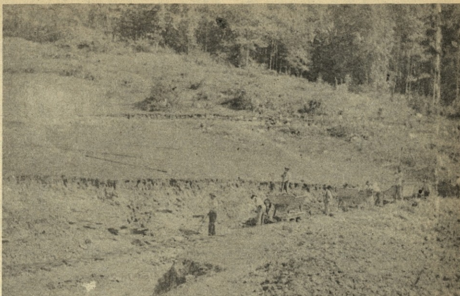
Začetna dela pri odpiranju površinskega kopa Dobrna leta 1908
