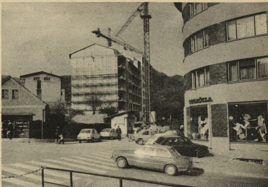
V novozgrajeni stanovanjski blok na ulici Sallaumines oziroma na Leninovem trgu so se koncem avgusta vselili številni novi stanovalci. Na voljo je bilo 86 stanovanj. Posnetek je še iz časa gradnje tega bloka (foto: A. Bregant)
