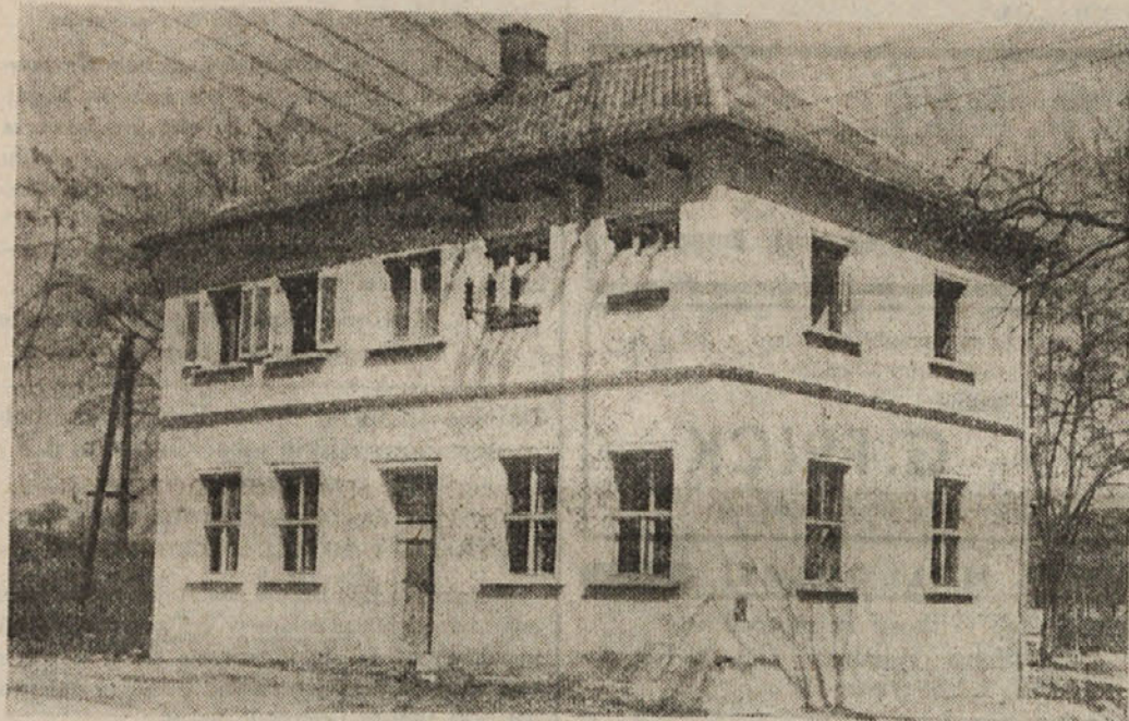
Nova transformatorska postaja v Borovljah
