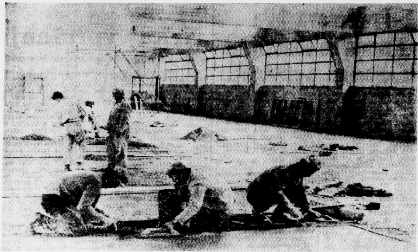
NAD 60 MILIJONOV ZA NOVO HALO — Mizarstvo podjetje v Senožečah je začelo že lani graditi novo poslopje, za katerega je zbralo 48 milijonov dinarjev. Gradbena dela gredo h kraju, še precej dela in sredstev pa bo treba za dokončno ureditev prostorov, v katerih bo tudi centralna kurjava. Stare prostore, ki so v dotrajeni hiši, pa bodo preuredili v skladišča. Foto: Selhaus
