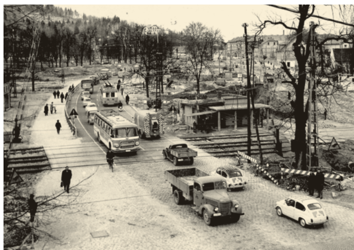
Gradbišče Celovška cesta, 6. 4. 1962 (Foto Pleterski – hrani ŽM)
