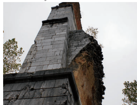
Ostank borovniškega viadukta
