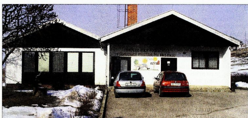
Obstoječa podružnična šola v Pristavi pri Mestinju bo letos svoj izgled povsem spremenila. Če ne bo posebnih zapletov, bodo začeli uporabljati nov prizidek že z novim šolskim letom.
