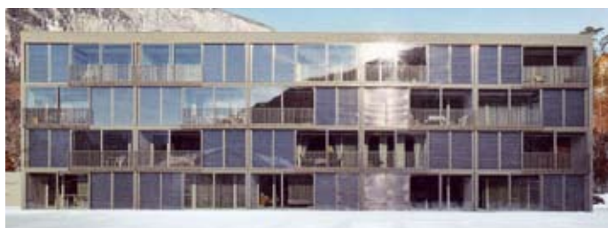
Slika 2: Gradivo s fazno preobrazbo je vgrajeno v zasteklitev fasade in pripomore k boljši energijski učinkovitosti stavbe in videzu fasade, ki glede na fazno stanje gradiva spreminja stopnjo prosojnosti [Ritter, 2007: 171].
