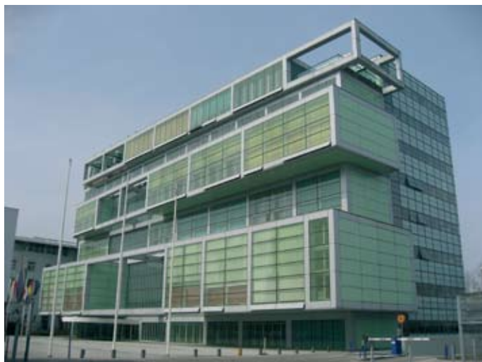
Slika 9: Sadar Vuga Arhitekti: prosto zamaknjena jeklena konstrukcija dvoran Gospodarske zbornice Slovenije v Ljubljani.
