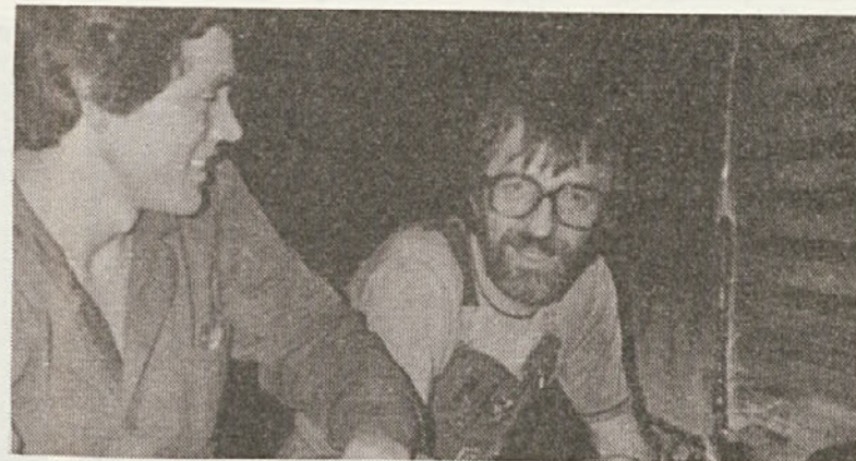
Luka Milutin (desno) dolgoletni delavec firme DURR, doma je iz Bačke Palanke, je bil zadolžen za adaptacijo E. C. peči na lakirnici drobnih delov. Pri varjenju izmenjevalca toplote in zgorevalne komore mu asistira naš vzdrževalec Lazar Lazarevič.
