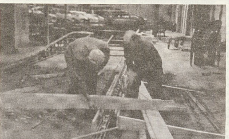
Stari železni navozi so kar prevečkrat klonili pod težo viličarjev, novi betonski navozi bodo gotovo odpornejši.
