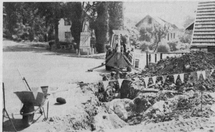
Izkop jarka za vodovod
