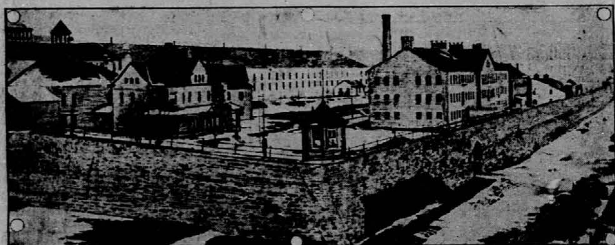
Zadnji čas so se pojavili v treh velikih ameriških kazniščih upori. V dveh slučajih so jetniki zapeli poslopja ter skušali pobegniti. Slika nam kaže pogled na Danemora kaznišnico.
