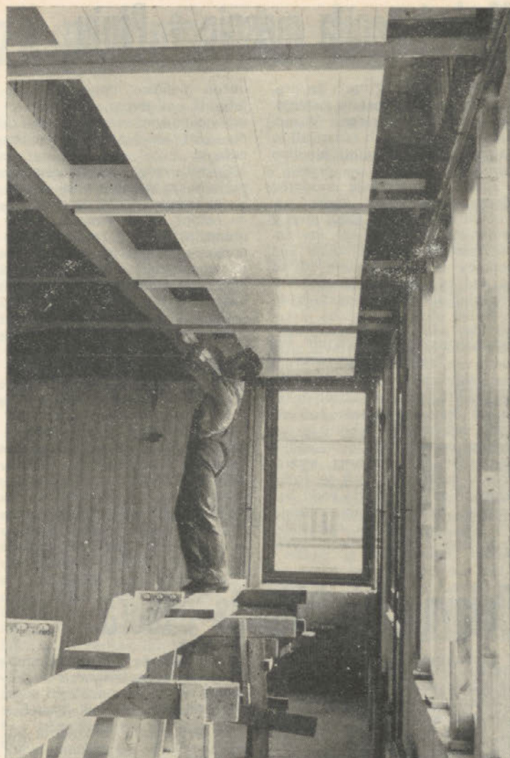
Montaža notranje opreme v poslovnem centru
