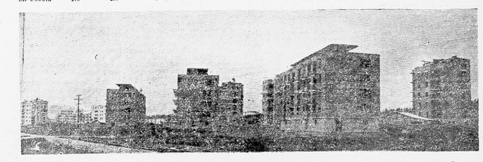
Gradnja novih stanovanjskih blokov v Velenju
