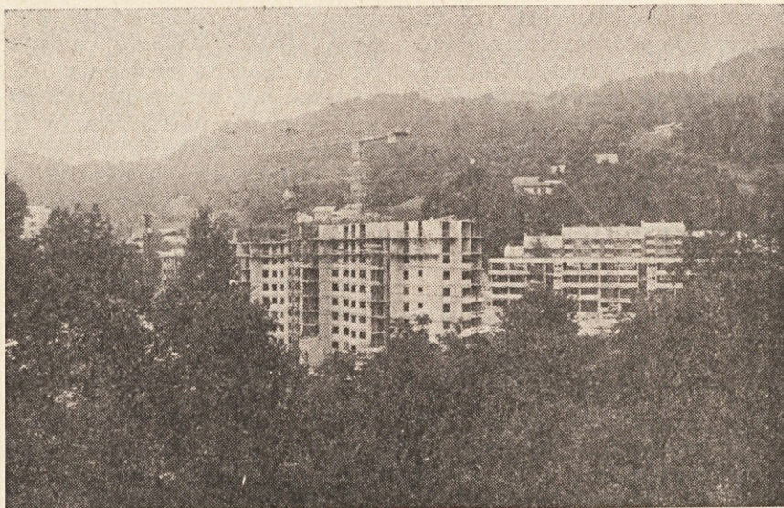
Ob ulici Sallaumines in na Leninovem trgu v Trbovljah poteka živahna gradbena dejavnost. Levo nov stanovanjski blok, desno upravno-poslovna zgradba za zavarovalnico, Zasavski računski center in druge naročnike.
