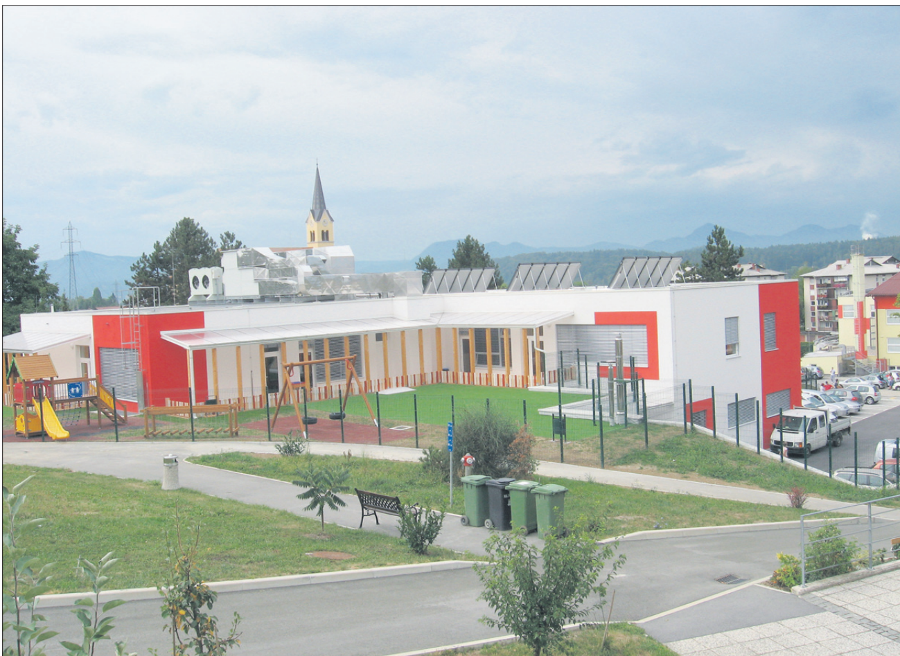
Nov energetsko varčen vrtec v Vojniku, fotografiran z zgornje strani. Zgradila ga je družba CMC, ki je začela – s pomočjo podizvajalcev – graditi še novo telovadnico.
