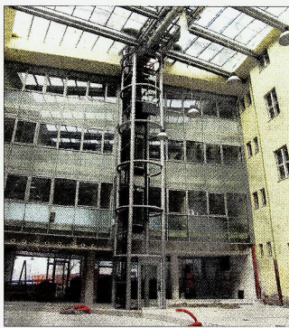
Z izgradnjo prizidka k Narodnemu domu je Celje pridobilo nov zapt atrij s stekleno strobo, v katerem bo tudi »šaltarjec« poslovanja upravne enote, zelo varjeto pa tudi nov privlačen prireditveni prostor.
