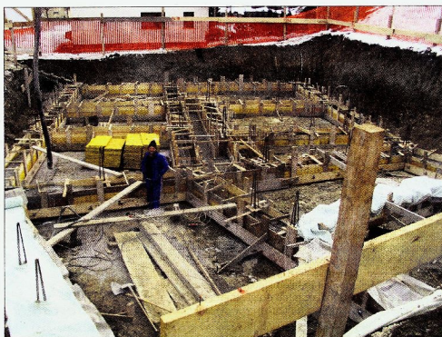
Temelji nove občinske stavbe v Podčetrtku, ki bo služila za različne potrebe, so dokončani. Odprtje napovedujejo za 24. junij.
