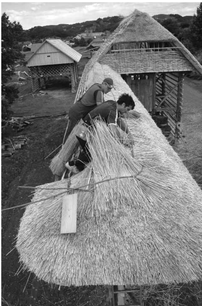
Krovca pri delu na Lukatovem topljarju. Foto Dušan Štepec, Arhiv ZVKDS, OE Novo mesto
