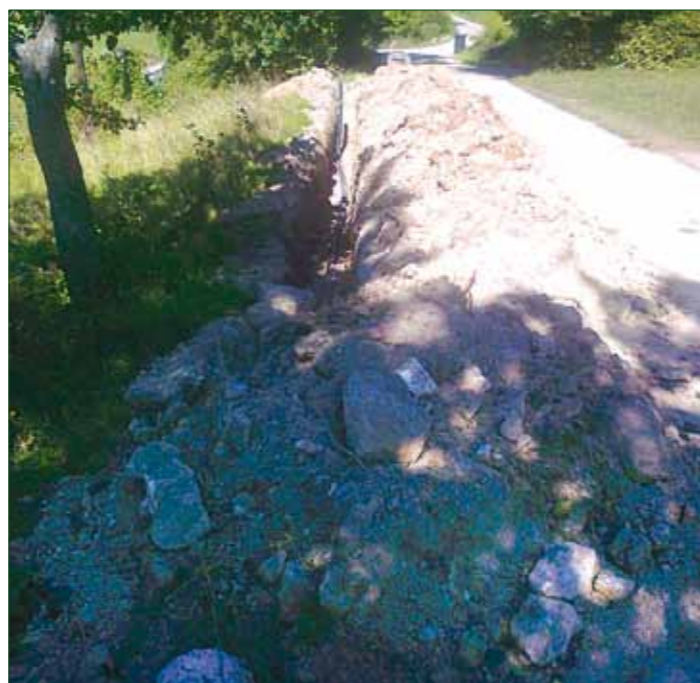
Obnova vodovoda v naselju Retje
