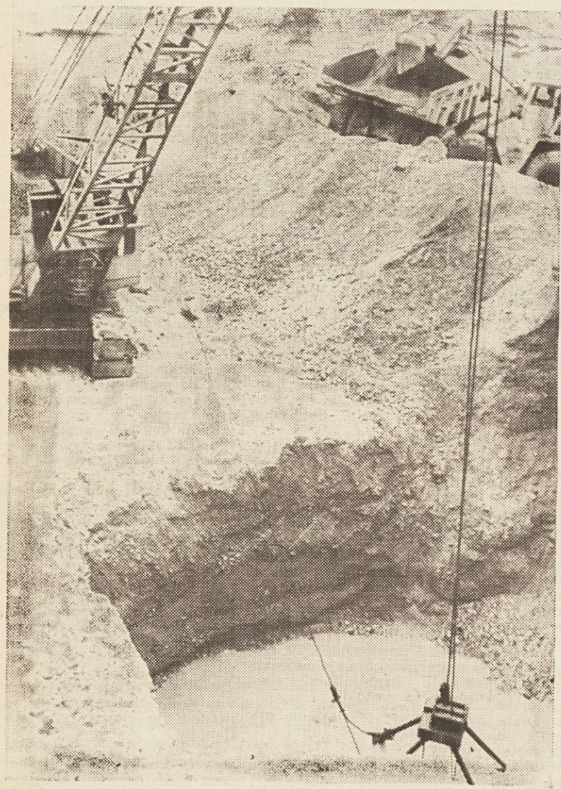
Izkop temeljev na Srednji Dravi
