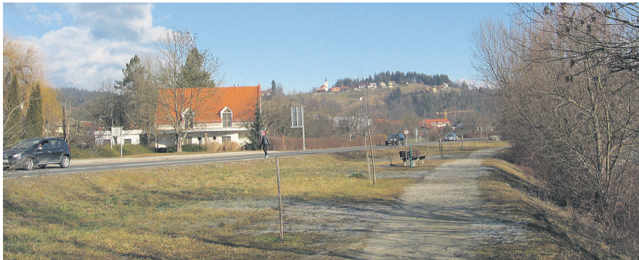
Mozirska sprehajalna pot ob Savinji ob glavni cesti skozi Zgornjo Savinjsko dolino. Prečkanje ceste na tem območju je nevarno, zato bo tam kmalu urejen prehod za pešce.
