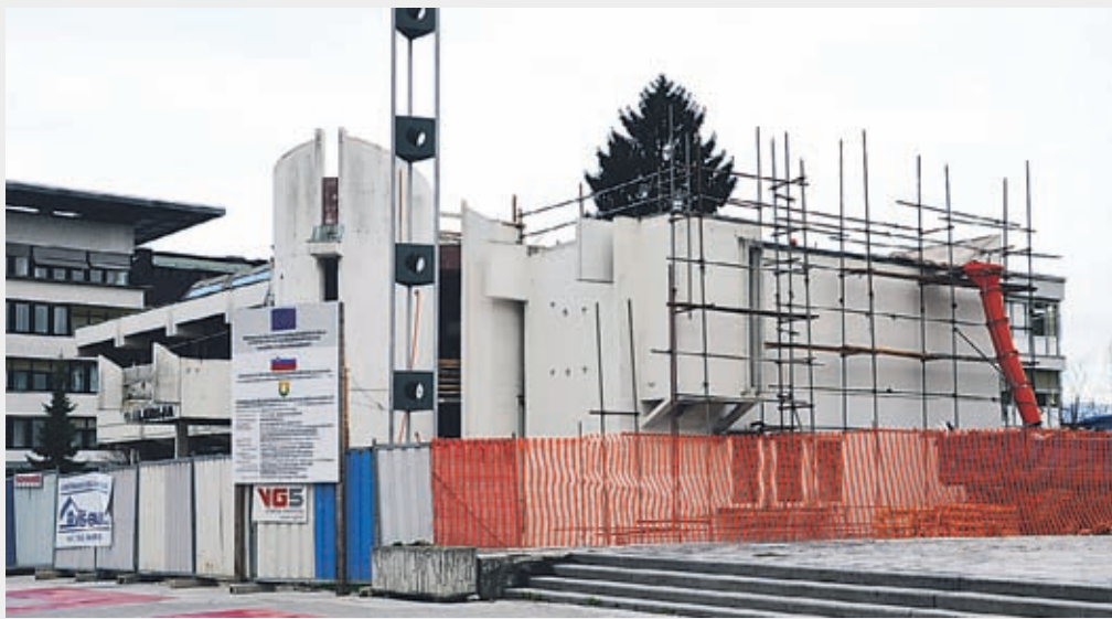
Obnova velenjske Galerije – stavba bo tudi energetsko učinkovitejša – zelo dobro teče. Gradbena dela naj bi bila končana že julija, do konca septembra bo v njej nova oprema. Oktobra naj bi zaživele tudi nove vsebine.
