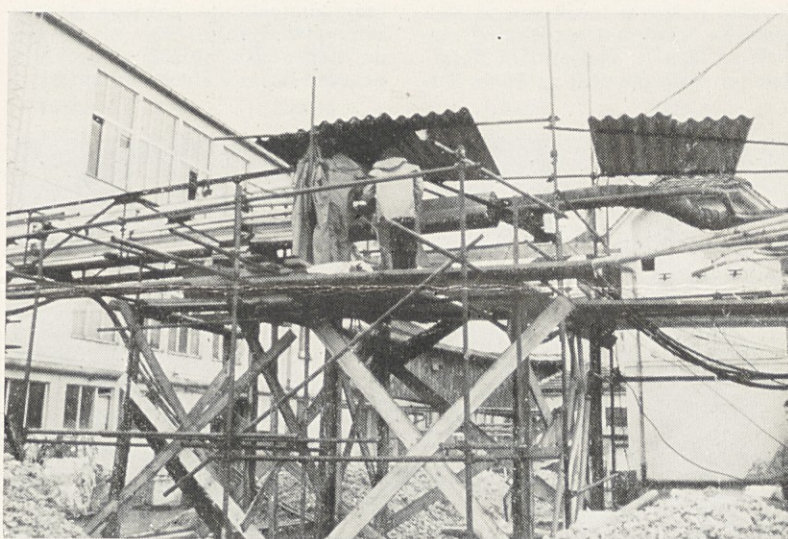
S popravili se je pričelo takoj. Delo je potekalo nemoteno ob vsakem vremenu
