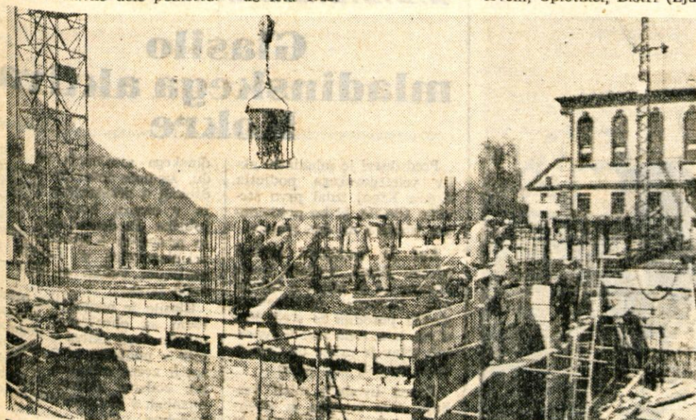
Zadnje čase dela pri gradnji kranjskega hotela lepo napredujejo. — Foto: F. Perdan
