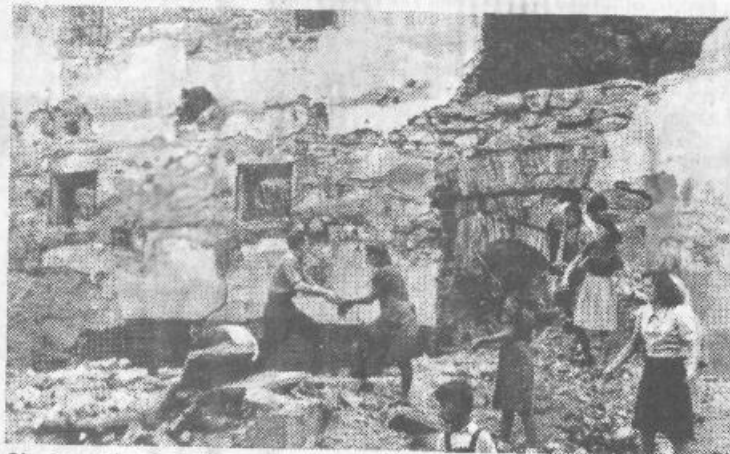
Obnova ruševin Rašice
