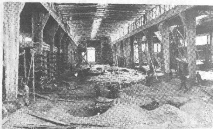
Gradnja tovarne Litostroj
