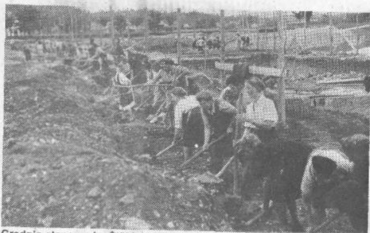
Gradnja stanovanj v Šiški
