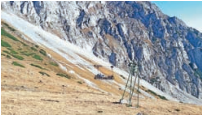
Tovorna žičnica do Kamniške koče na Kamniškem sedlu je bila zgrajena že leta 1955, zato zahteva drago redno vzdrževanje (na sliki). Okolju in planinskemu turizmu mnogo bolj prijazna bi bila elektrifikacija. / FOTO: JASNA PALADIN
