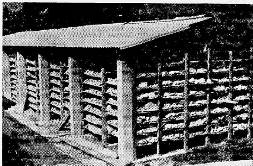
V takšnem vagončku pripeljejo naenkrat do sušilnic okrog 1000 kg krede in jo naložijo na police, kot prikazuje naša slika.
