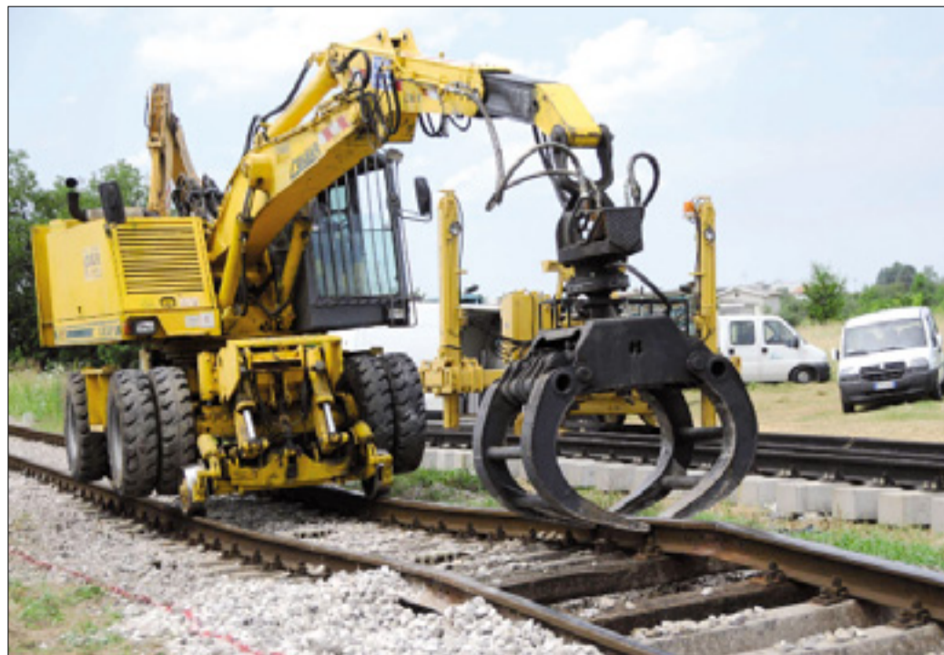
Nov železniški element so v nedeljo namestili s kopačem
