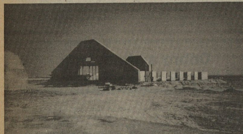
Betonske polizdelke smo izdelovali sami (Foto: A. L.)
