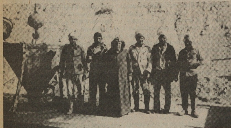
V objekte, ki nam jih je zaupal investitor, je bilo treba v šestih mesecih vgraditi okrog 2.500 prostorninskih metrov betona. To delo je v pretežni meri opravila skupina na sliki
