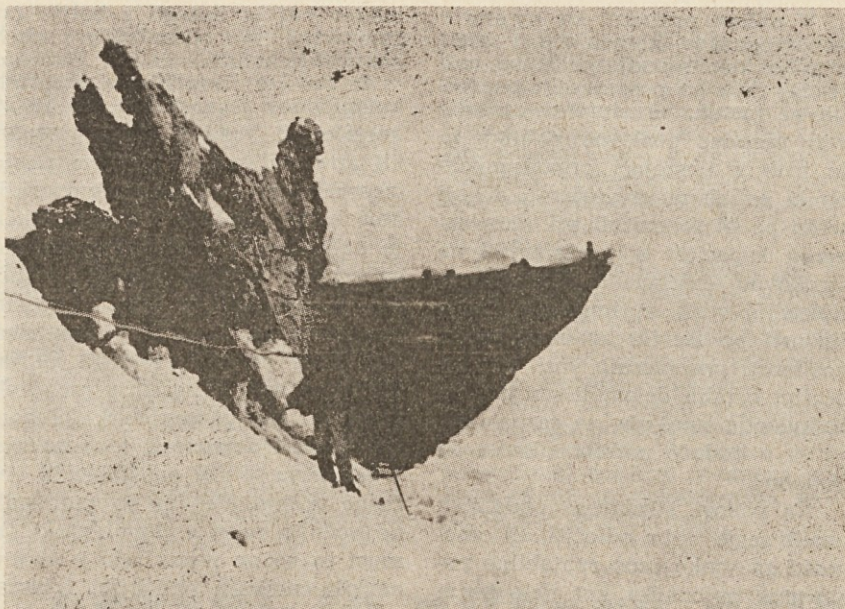
Zima na gradbišču OSRD v Nikšiču, rov je deloma zasut s snegom — marec 1970 Foto: inž. Franc Starman
