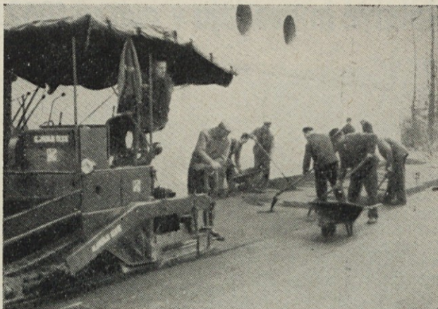
Zaključna dela pri asfaltiranju
