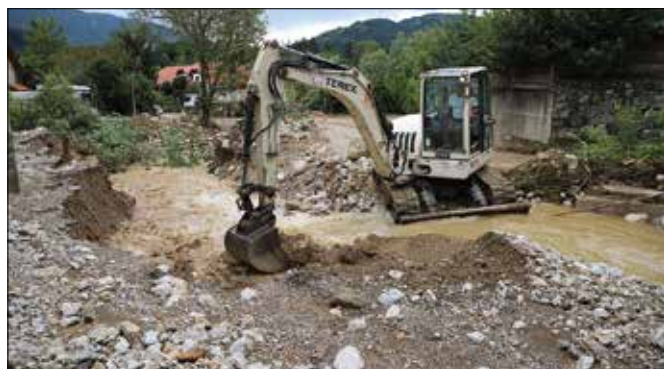
Sanacija plazu pri Prodniku v Juvanju
