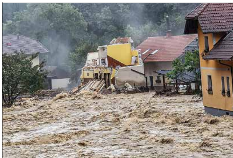
V zaselku Struge so objekti poplavljeni, dve hiši pa sta uničeni.
