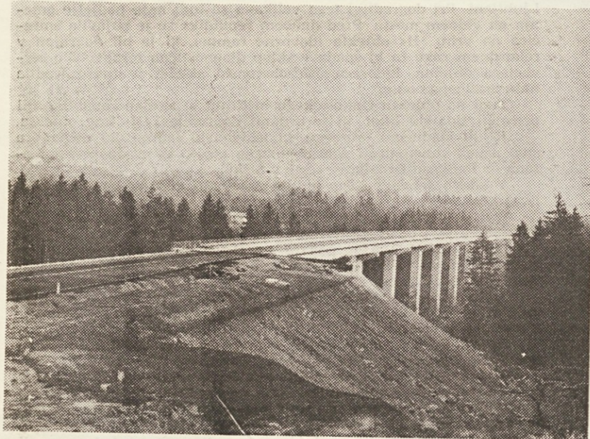
Viadukt Preloge v dolžini 559 m bo kmalu služil svojemu namenu
