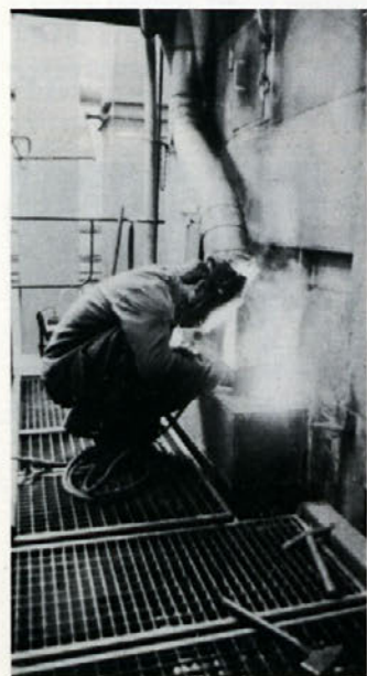
Popravlilo parnega kotla v kotlarni Titanovega dioksida
