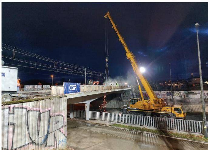
Slika 3. Pogled na pritrditev prednapete AB-plošče na avtodvigalo.
