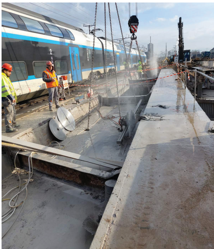
Slika 5. Rezanje prednapete AB-plošče s krožno žago.
