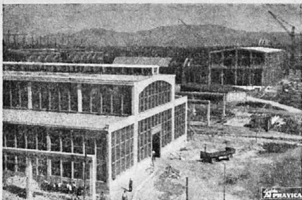
Titovi zavodi »Litostroj« med gradnjo
