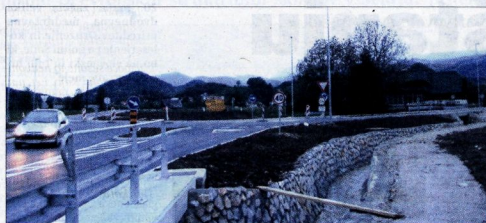
Zaradi novega krožišča pri Novi Cerkvi je prišlo do podpisovanja peticije tamkajšnjih pešcev in kolesarjev. Na okrasno fontano niso pozabili, za pločnik in kolesarsko stezo pa niso poskrbeli. Občina je zato v preteklih dneh uredila zanje zasloni kolovoz (na desni strani fotografije).
