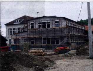
Z gradbišča velikega prizidka osnovne šole na Frankolovem. V kraju ga težko pričakujejo.
