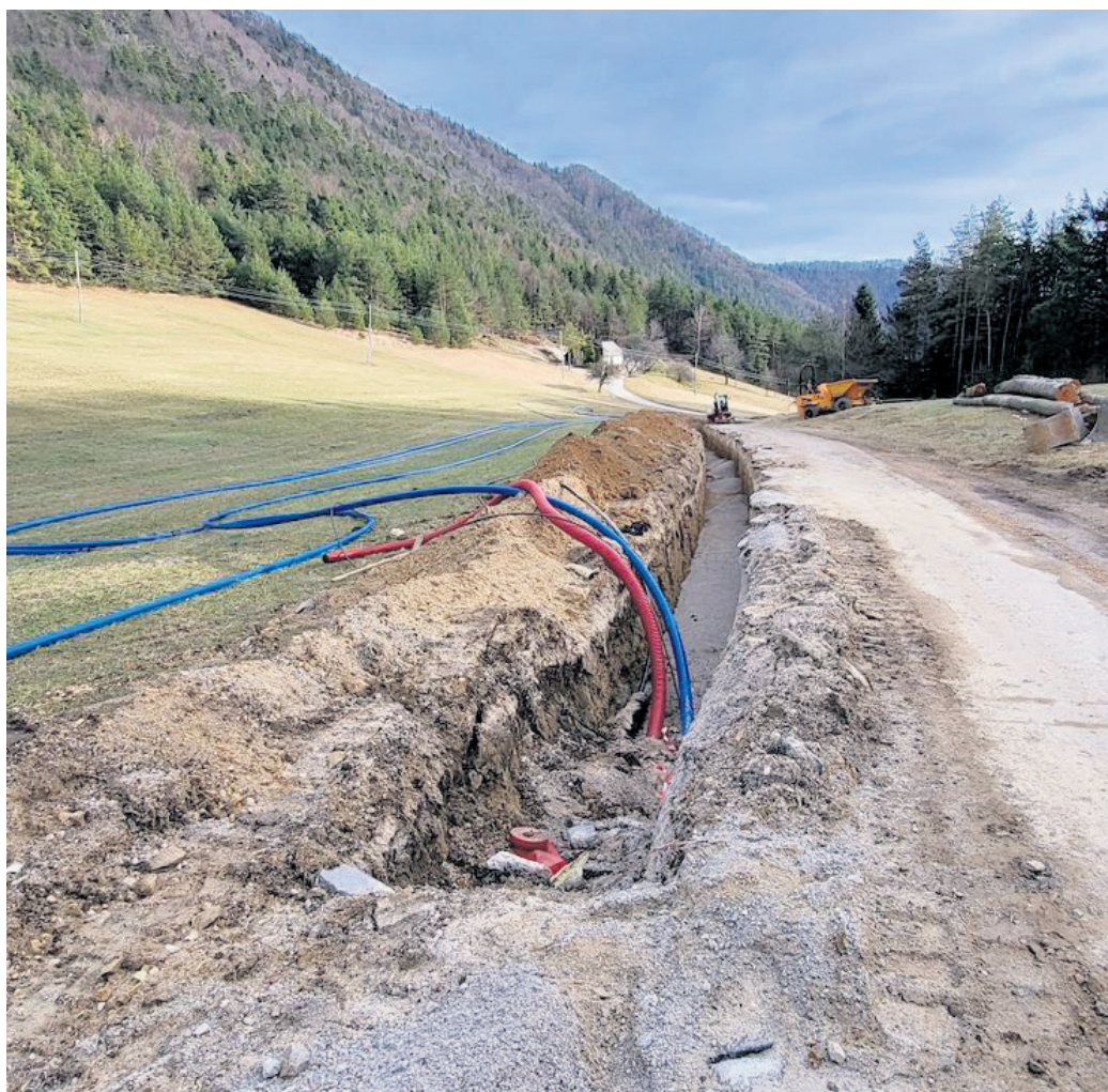
Prebivalci Lindeka pri Frankolovem naj bi še v tem letu dobili dostop do javnega vodovodnega omrežja. Hkrati z gradnjo vodovoda bosta na tem območju urejena tudi električna napeljava in optično omrežje. (Foto: Mateja Kozikar)
