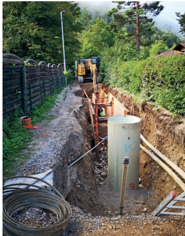
Gradbišče v Iški
