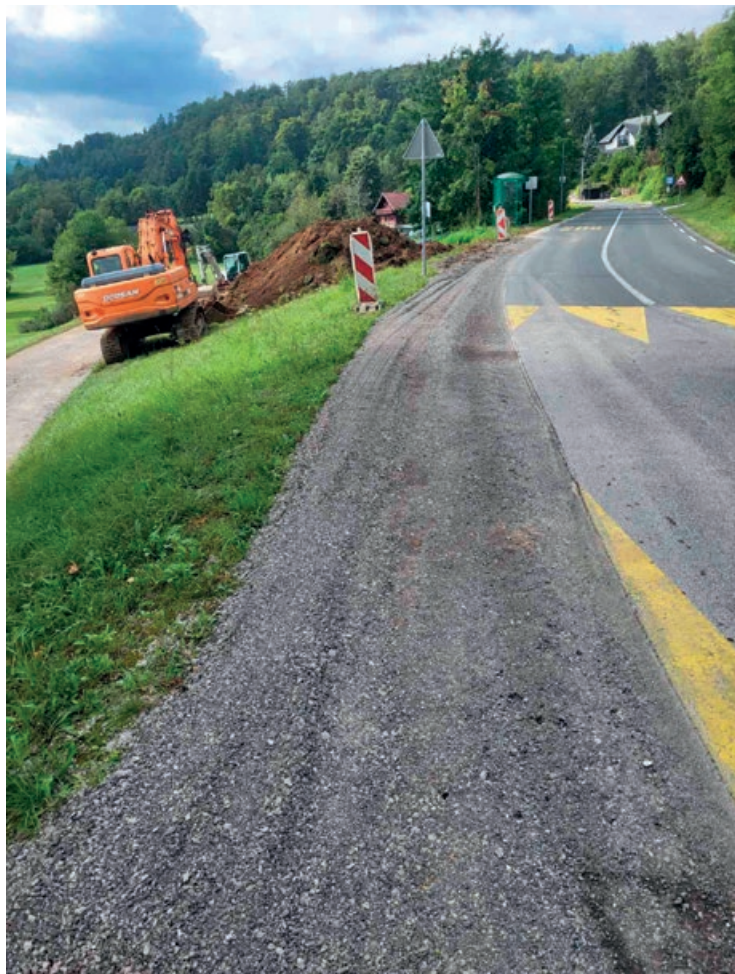
Gradnja vodovoda v Podgozdu
