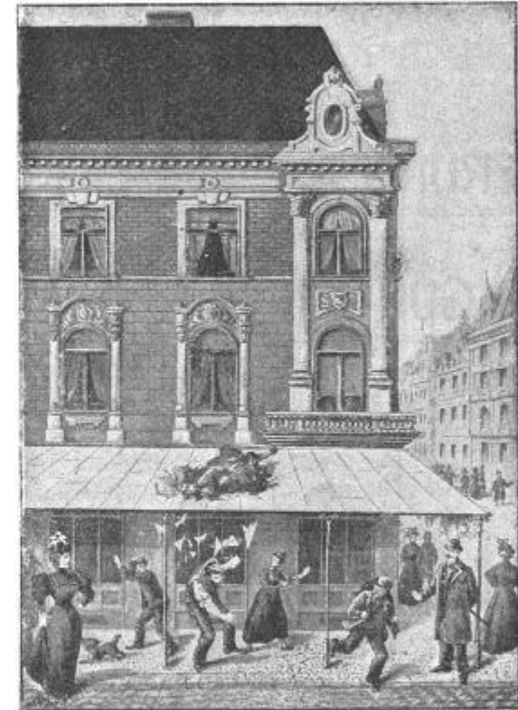
Sturz auf eine Veranda, eingedeckt mit gewöhnlichem Glas ohne Drahteinlage. Die Verunglückte stürzt durch das Glas hindurch, auf die unter dem Dache befindlichen Personen, welche durch die herabfallenden Glasrümmen in grosse Gefahr gebracht und theilweise schwer verletzt werden.
