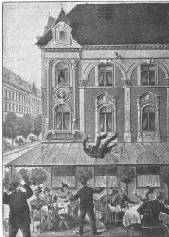
Sturz auf ein Dach, eingedeckt mit Drahtglas. Das Drahtglas widersteht dem Sturze; der Abstürzende bleibt, ohne durchzubrechen, auf dem Glase liegen, ohne dass die unter dem Dache befindlichen Personen beschädigt werden. (Siehe Attest der Ingenieur-Section Villach.)
