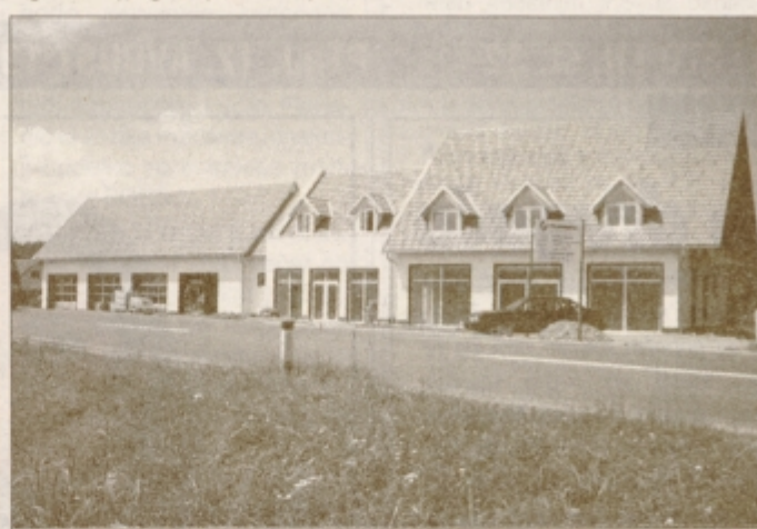
Nov objekt Nissan na Mariborski cesti
