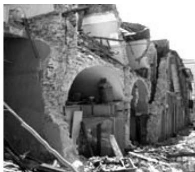
Slika 3 • Zunajravninska porušitev zidov zaradi a) slabe povezanosti konstrukcijskih elementov ( http://db.nzsee.org.nz/Seminars/2014/Lagomarsino_Wellington_2014-2-20.pdf ) in b) slabe povezanosti zidovine (Silva et al., 2014), L'Aquila, Abruzzo, Italija, c) porušitev stropa bazilike sv. Frančiška Asiškega v Assisiju med potresom v regiji Umbria-Marche leta 1997 ( http://projecthistoryitalia.altevista.org/26-settembre-1997-terremoto-nelle-marche-e-in-umbria/ )
