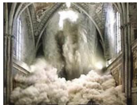
Slika 3 • Zunajravninska porušitev zidov zaradi a) slabe povezanosti konstrukcijskih elementov ( http://db.nzsee.org.nz/Seminars/2014/Lagomarsino_Wellington_2014-2-20.pdf ) in b) slabe povezanosti zidovine (Silva et al., 2014), L'Aquila, Abruzzo, Italija, c) porušitev stropa bazilike sv. Frančiška Asiškega v Assisiju med potresom v regiji Umbria-Marche leta 1997 ( http://projecthistoryitalia.altevista.org/26-settembre-1997-terremoto-nelle-marche-e-in-umbria/ )
