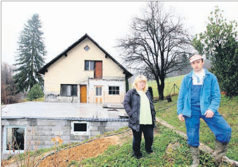
Slavica Zemljak in Boris Čuber ob stari hiši, ki jo čaka le še rušenje, ter ob novozgrajeni garaži, ki naj bi bila tudi osnova za gradnjo nove domačije. Geologi so dali zeleno luč, v pripravi pa je načrt objekta, ki bo podlaga za pridobitev gradbenega dovoljenja.
