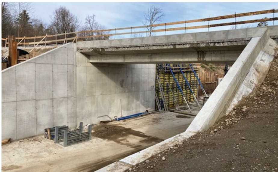
Slika 5. Zasip za kesonom z izkopnim materialom (februar 2022).
