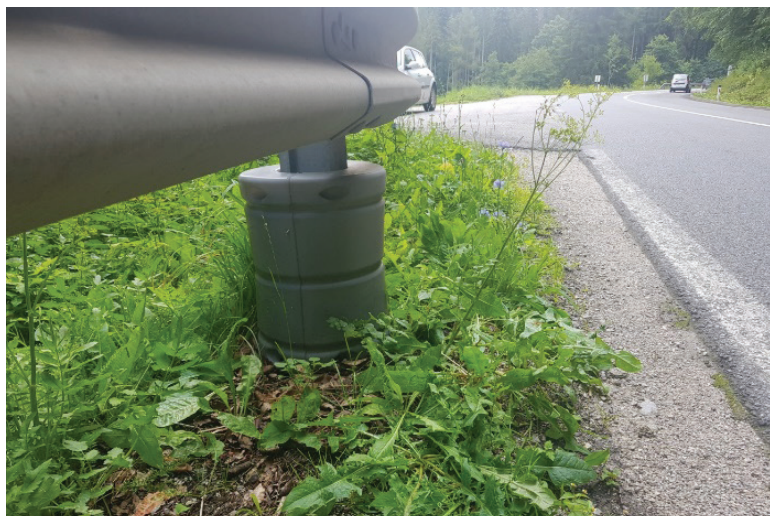
Slika 6. Pravilna postavitev in gabaritne oblike blažilca trka motorista za steber jeklene varnostne ograje.
