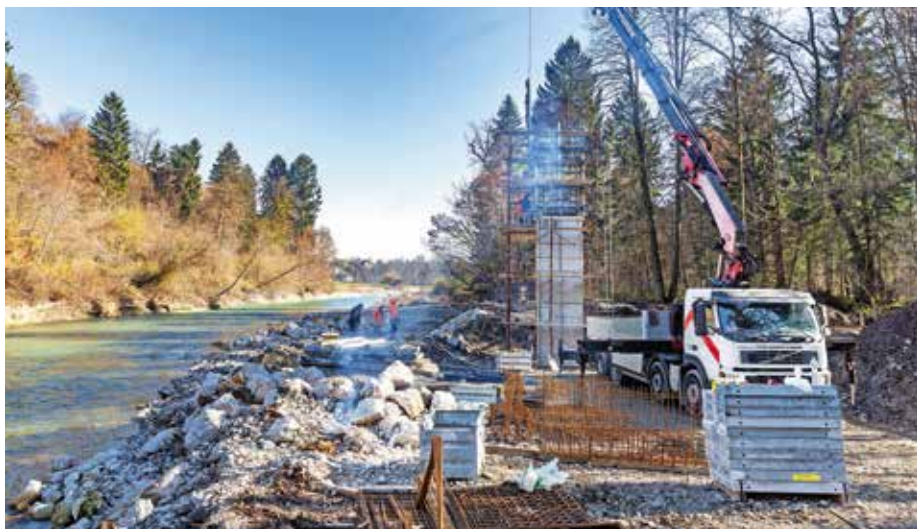
Rekonstrukcija poteka od sredine poletja. Brv bo stala na obnovljenih nosilcih, ki bosta dodatno utrjena s piloti in razširjena z dobetoniranjem. / Foto: Peter Košenina
