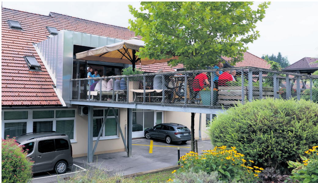
Nova enota doma starejših bo zgrajena v bližini enote, ki lahko trenutno sprejme 19 stanovalcev.
