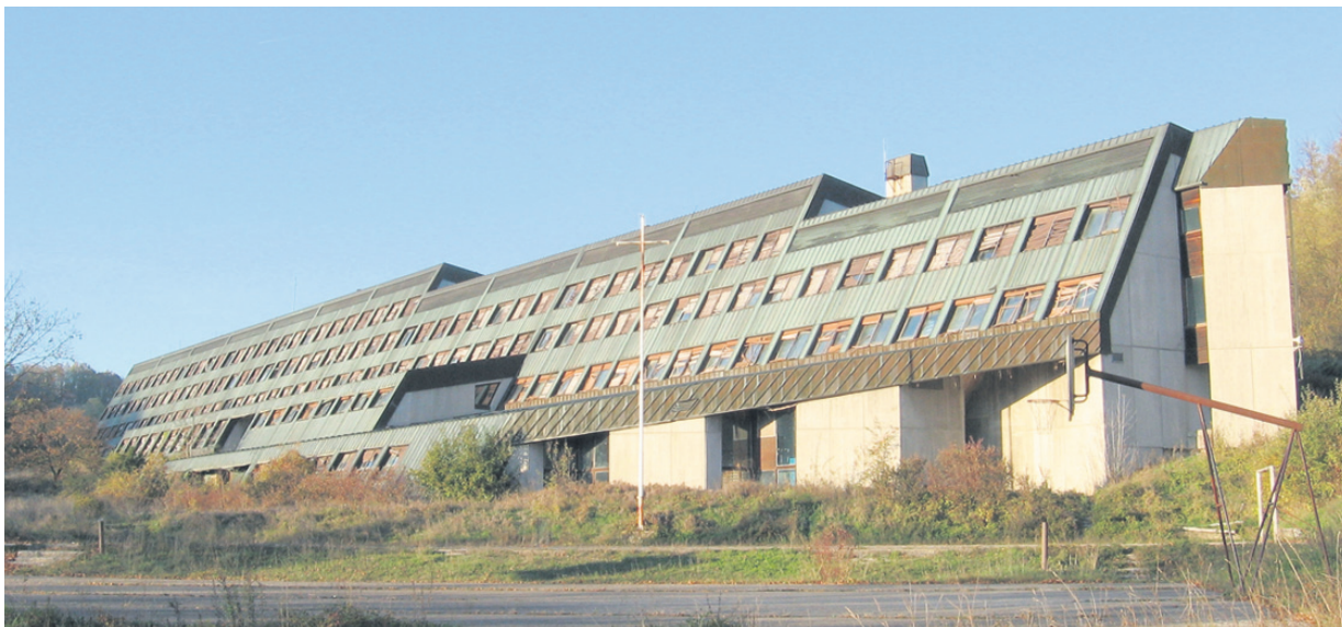
Nekdanja politična šola zveze komunistov v Kumrovcu propada. V ogromni stavbi so bili nekaj časa vojni begunci, nato se vse do danes pojavljajo imena različnih investorjev. Pred gospodarsko krizo se je za stavbo resno zanimala družba Terme Olimia iz bližnjega Podčetrka.
