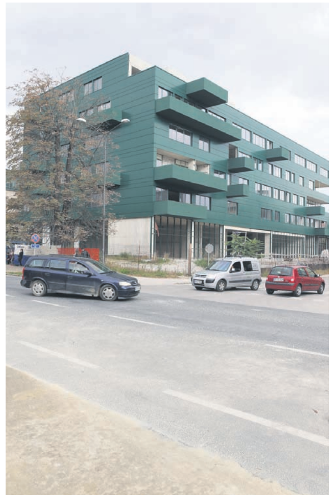
Ob začetku gradnje so v podjetju Reparo napovedali, da bodo Medicinski center Glazija zgradili do konca leta 2011. V njem naj bi bili zasebne zdravniške in zobozdravniške ambulate ter diagnostični centri.
