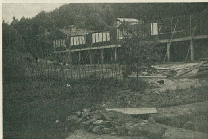
Osnovna šola v Sentjanžu v izgradnji
