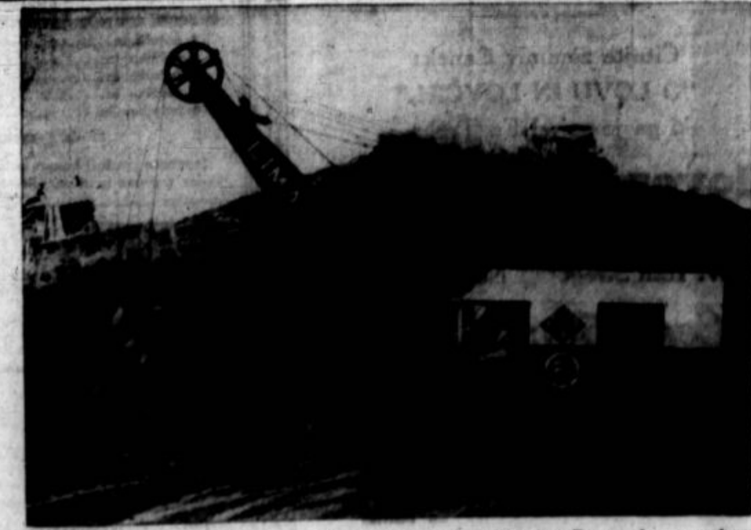
Parna lopata dviga semljo, kjer bo zgrajena nova zatvornica Panamskega prekopu.
