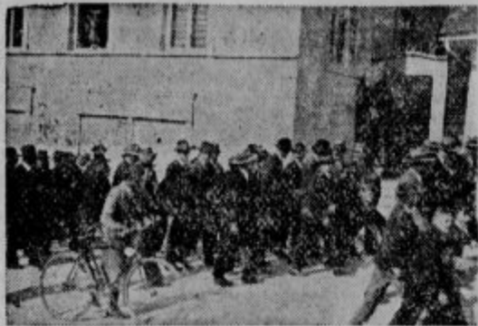
Koroški pevci korakajo v Kranj.
