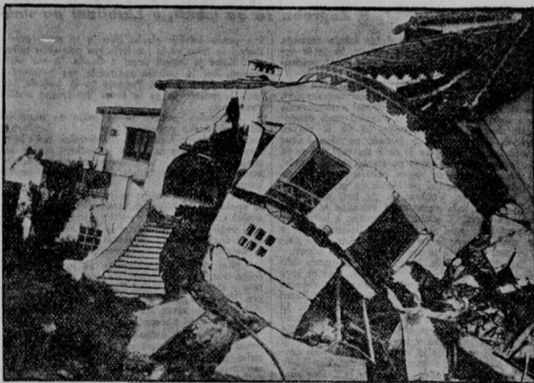
Na gorenji sliki vidimo podrti hišo župana mesta San Clemente v Kaliforniji. 60 metrov visok skalnat hrib nad mestom se je udril in pokopal ter porušil več hiš. Železniški tir je zasulo 100 m na daleč
